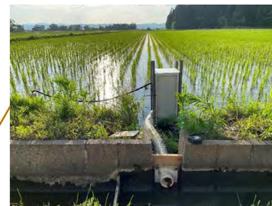
止水板にフリー傾斜パイプ(カナイ製)を固定(秋田県)
